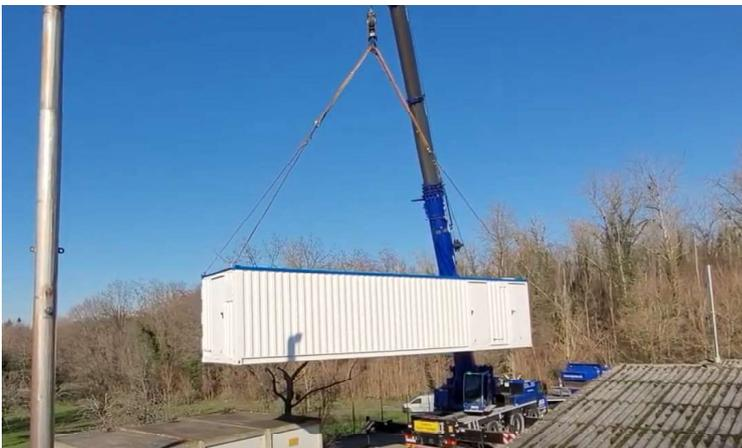
Abbildung 1: Aufstellung der neuen Sickerwasserbehandlungsanlage
