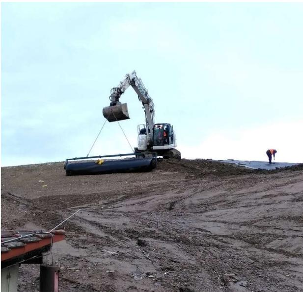
Abbildung 1: Bagger transportiert eine Rolle Folie
